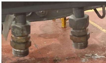
Figura 1. Ejemplo de toma roscada tipo racor Gas ½”.
